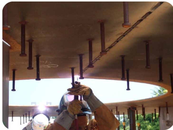
外槽底部ライナの溶接
