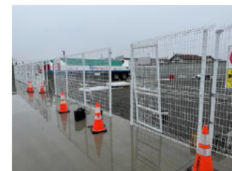
フェンス工事
