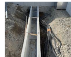
配管トレンチ工事
