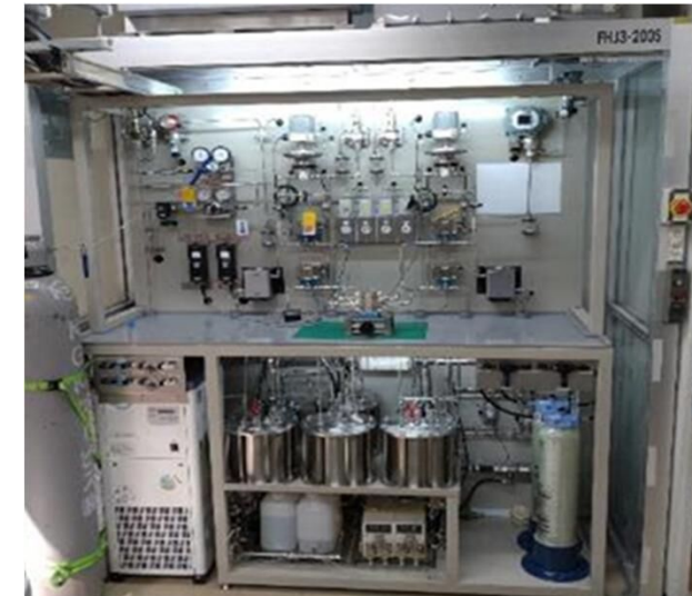
図1 電解装置外観
