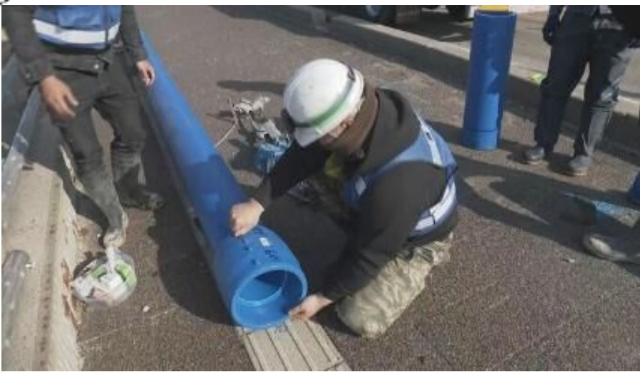
水道配水用PE管施工の様子
