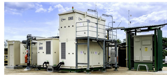
ナフサクラッカーにCO 2 回収装置及びオレフィン合成反応器を併設し、海外実証中（タイ）
