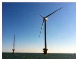
写真4: 洋上風力発電実証 （左）銚子沖、（右）北九州市沖
