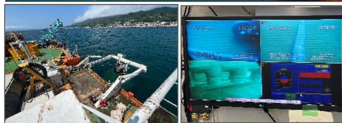
ケーブル埋設
