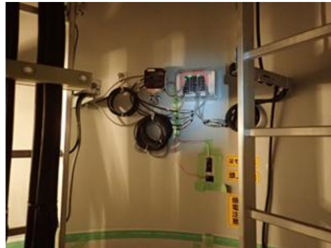
タワー部のひずみゲージ貼付状況
