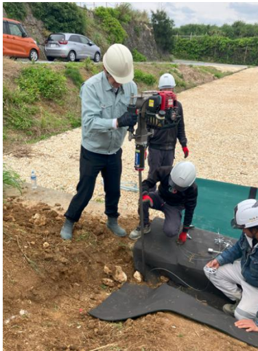
耐風性向上のための特殊アンカー施工
