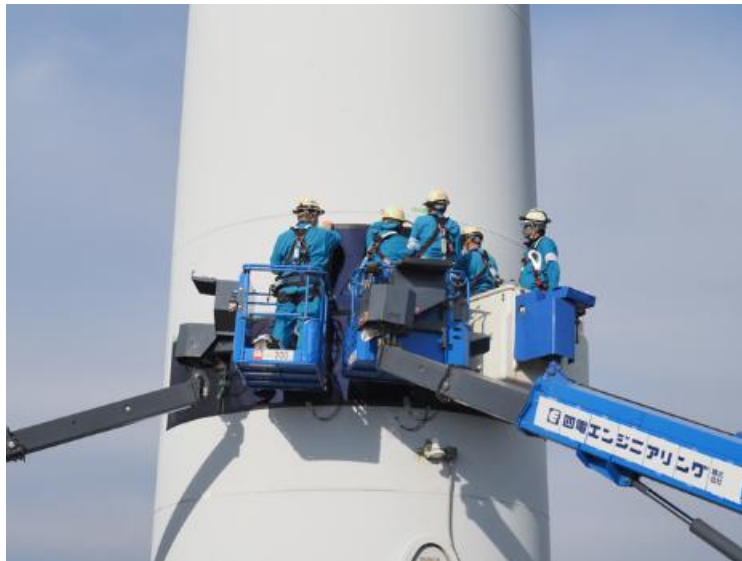
風力発電タワーへの設置状況
