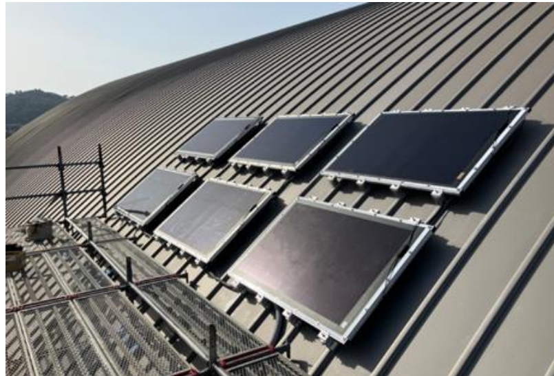
アーチ型屋根への設置
