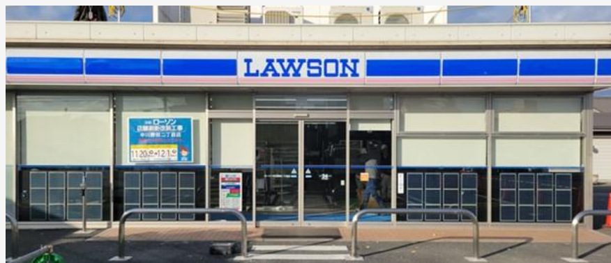
店舗窓枠内側への取付け
