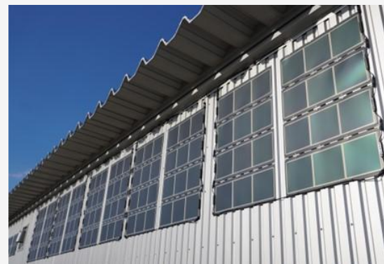
壁面への設置(南西面)
