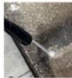
(コンクリート洗浄の例)
