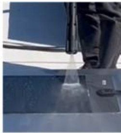
高圧洗浄(高さ10cm)
