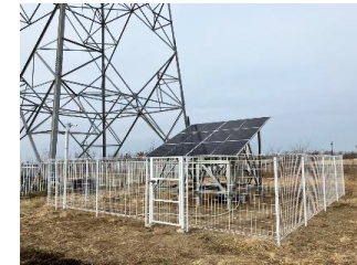
(3)周囲に環状接地線を埋設
