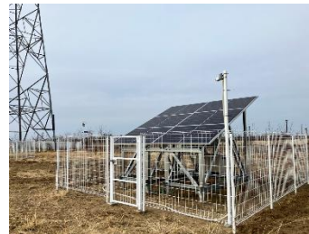
(2)架台下部をIV線で接続
