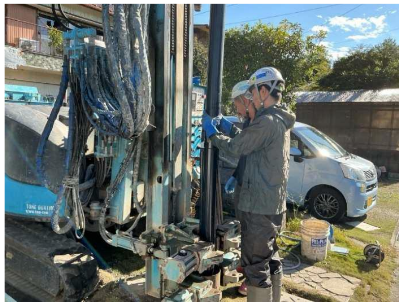
還元井掘削作業 (2025/10/23撮影)
