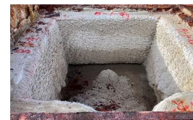
スケールが付着した 熱水槽
