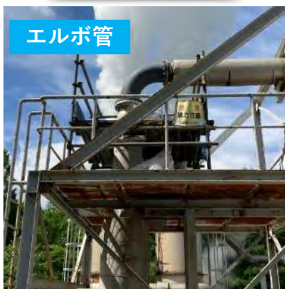
生産井蒸気配管の暴露試験を実施
