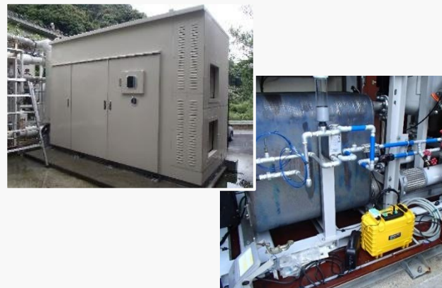
金属腐食対策
