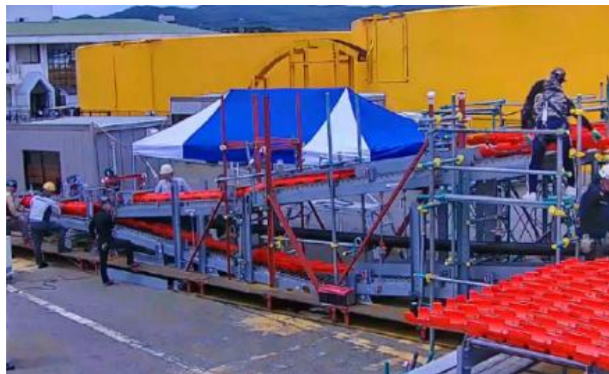
防護管高速取付実機検証
