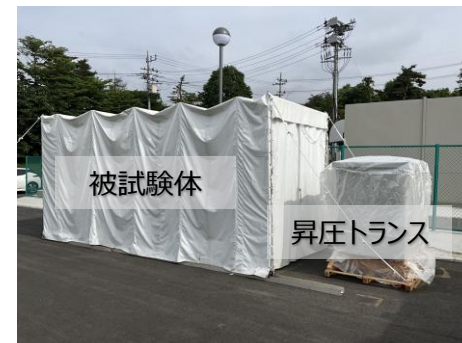
A社S-GFL・GFMインバータ設備
