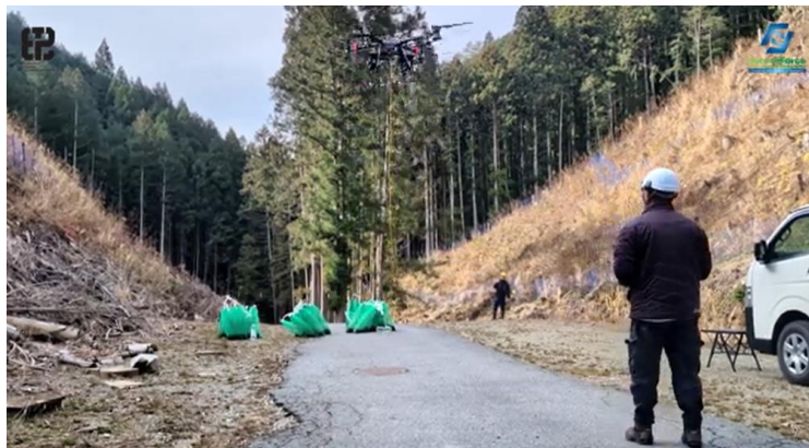
荷上げの様子（荷上げ側）
