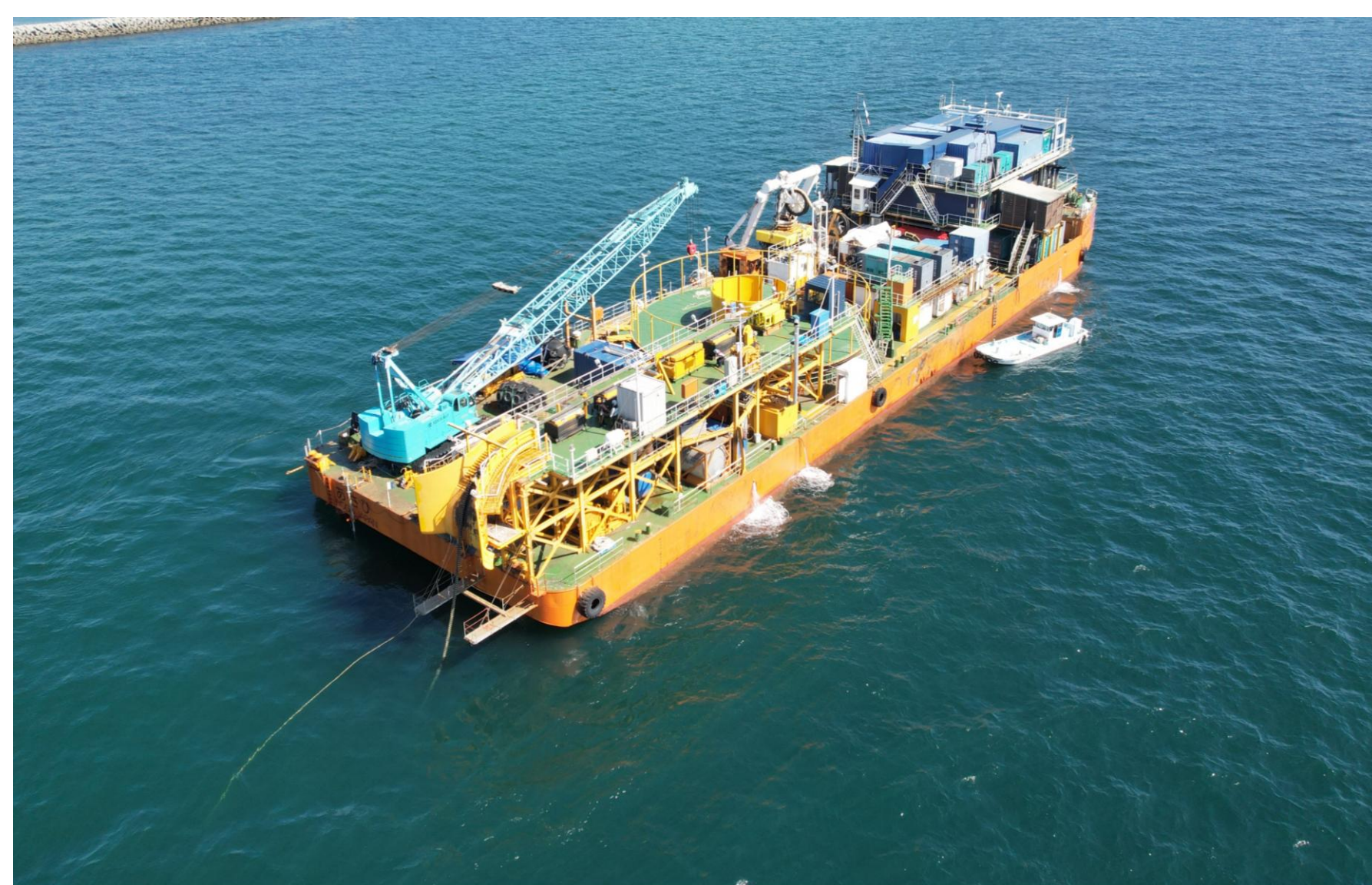
実海域実験状況 (ケーブル敷設状況)
