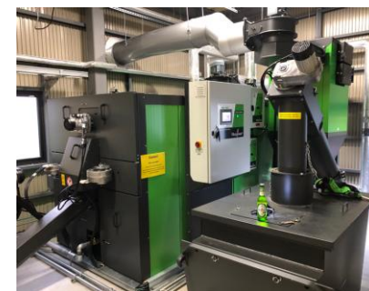
小型チップボイラ(例) (低質燃料対応)
