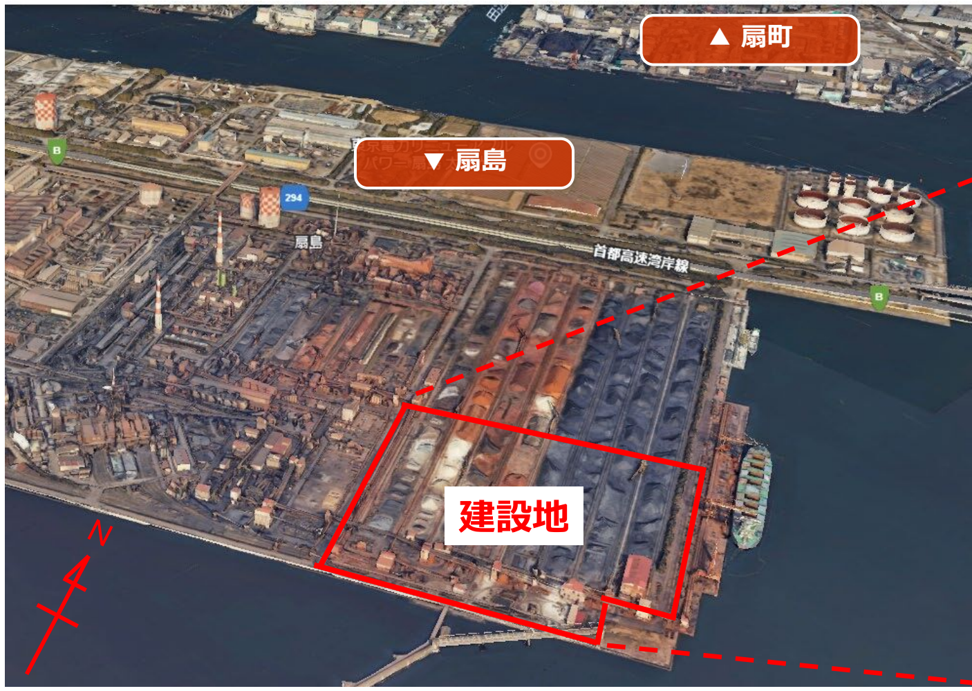
図① 基地建設地（出典：Google Earth） （JFEスチール東日本製鉄所京浜地区・川崎市扇島）
