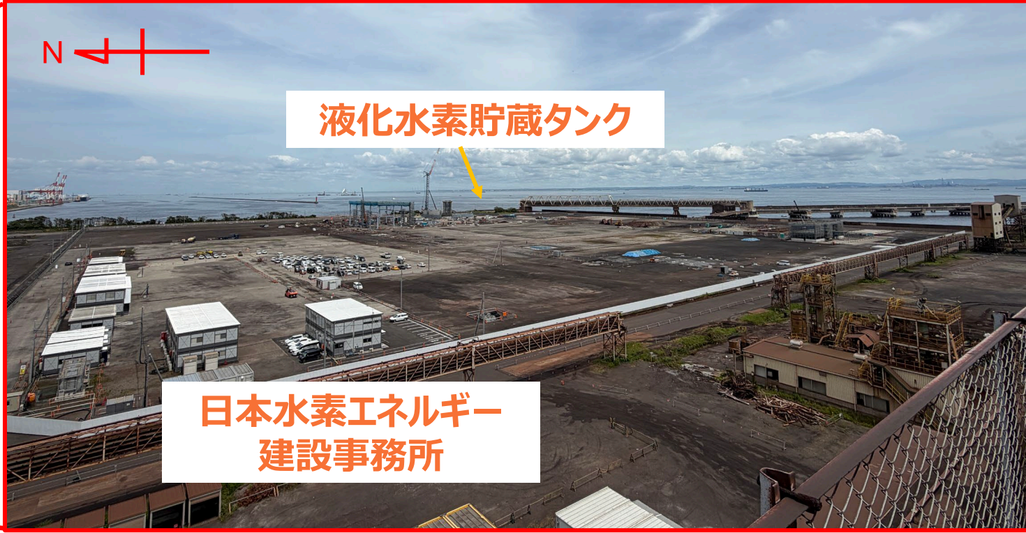
図② 国内基地の建設状況（2026/5/26）
