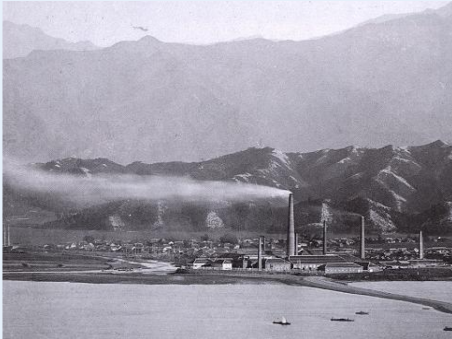
愛媛・新居浜／当時の銅製錬所の遠景 (写真提供：住友史料館)
