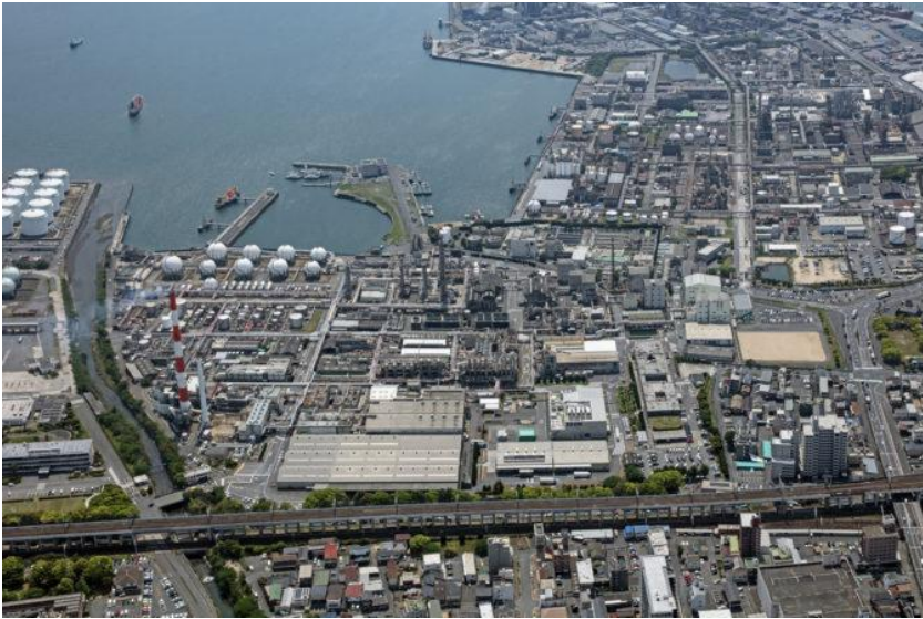
設備を設置した周南市徳山工場
