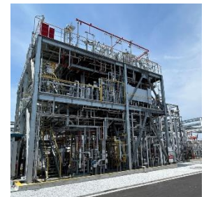
エタノールからプロピレンを直接製造するパイロット設備
