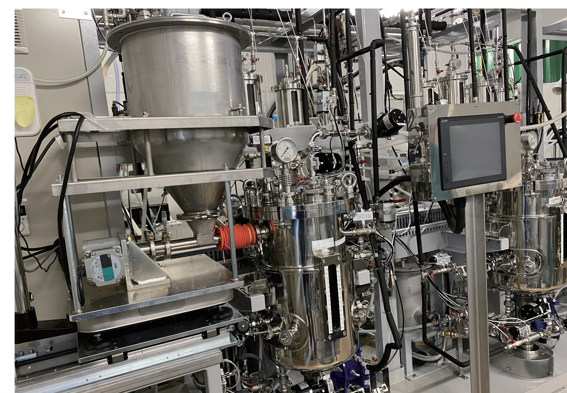
稼働中ベンチプラント Operating bench-scale plant
