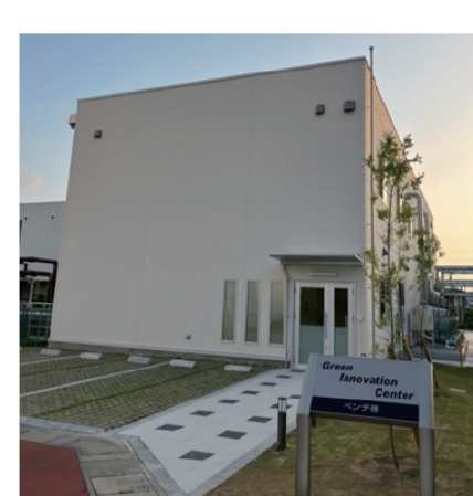
ベンチ設備：25/03稼働
