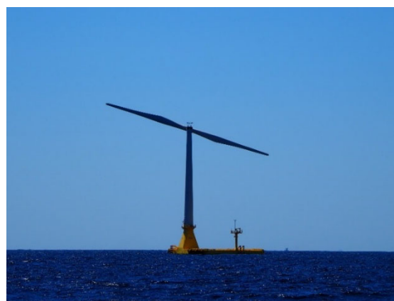
実証運転中の「ひびき」
