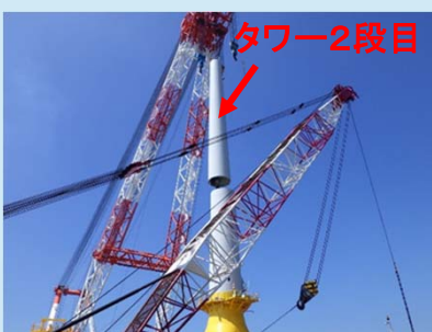
写真 タワー2段目搭載 ※2
