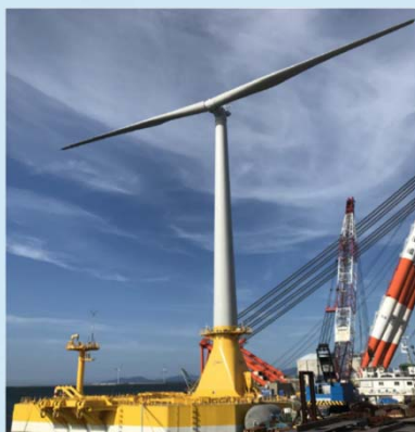
写真 組立完了
