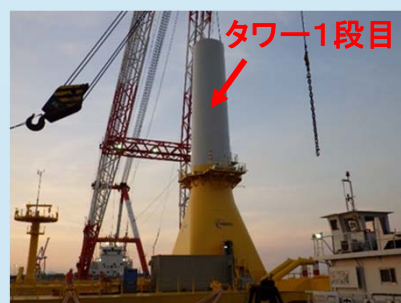
写真 タワー1段目搭載 ※2
