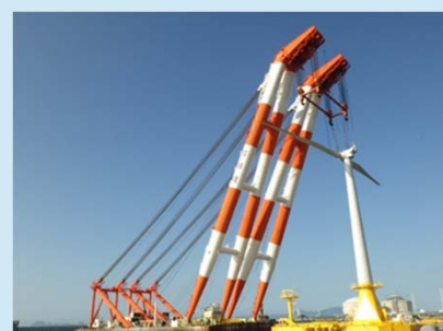
写真 タワーへのRNA搭載
