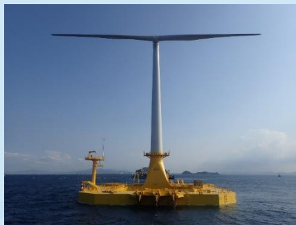
写真 設置完了
