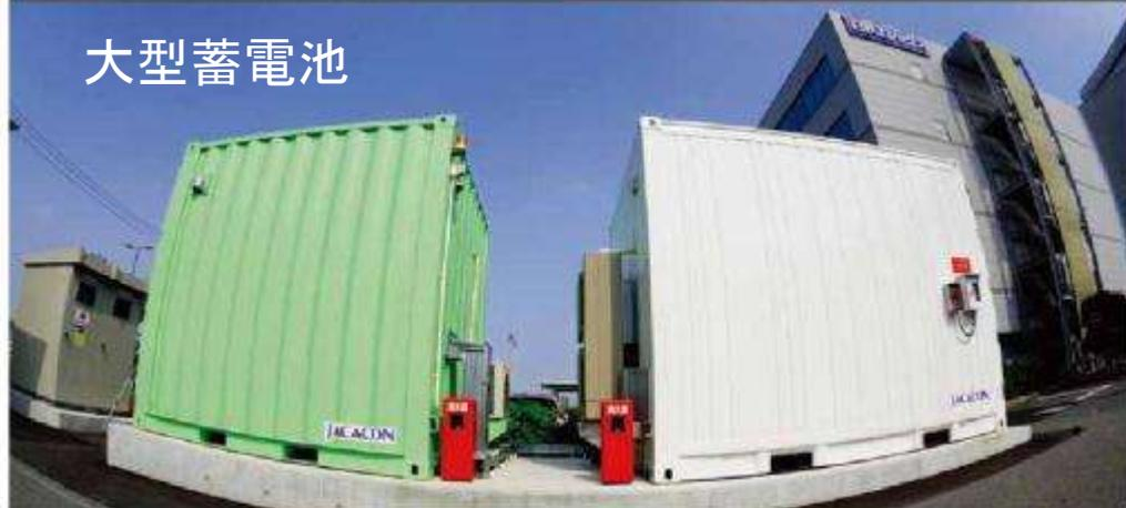
上: 日鉄エレクトクスのBEMSによるエネルギー 稼働状況, 下: 40kw、50kwの大型蓄電池
