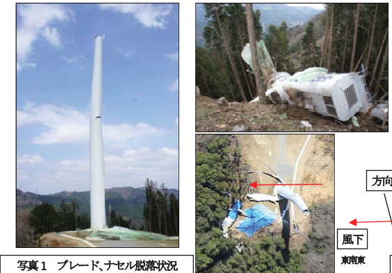
写真1 ブレード、ナセル脱落状況
